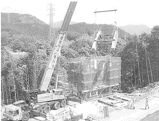
写真 - 3 メラン材架設状況
