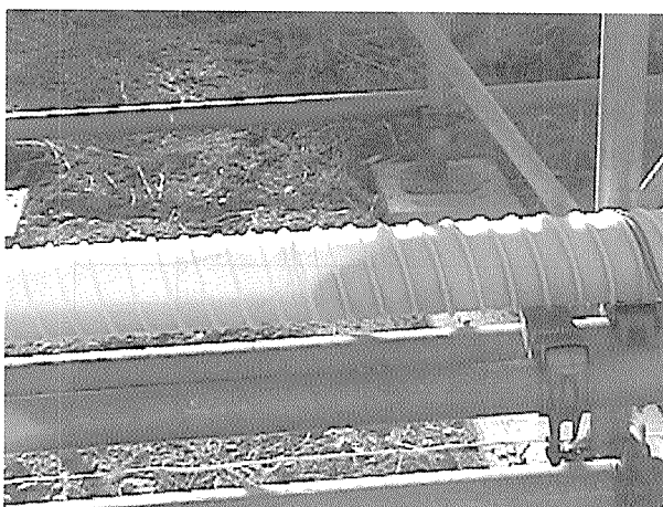
写真-5 水平部分の注入状況
