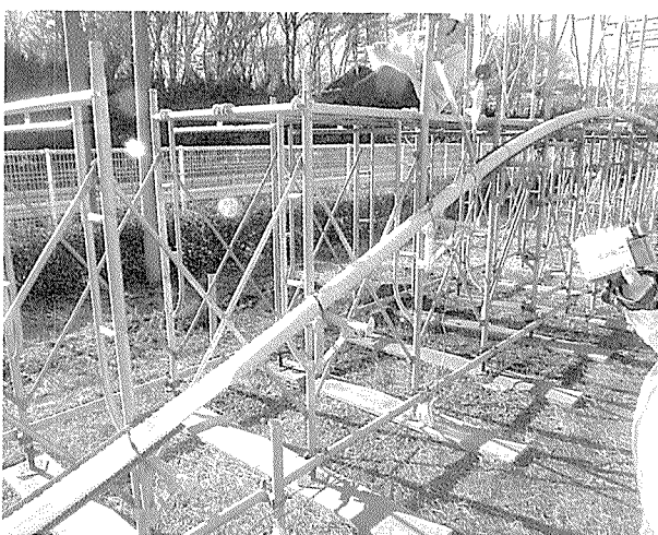
写真-4 第一凸部付近の先流れ (本試験)
