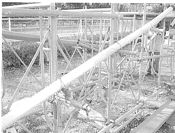
写真-3 注入口直後の先流れ (本試験)
