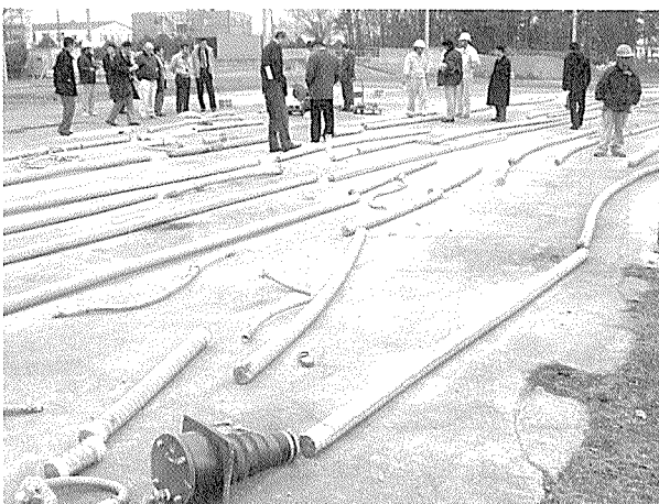
写真-6 硬化後の切断確認状況
