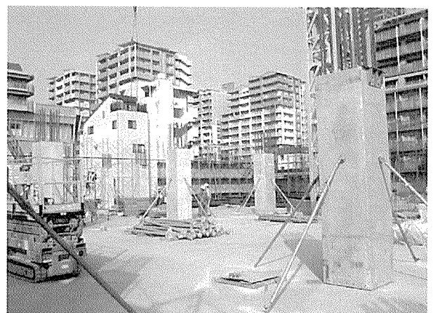
写真 - 4 建方の完了した柱 PCa 部材
