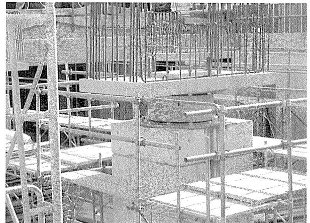
写真 - 2 免震材料の設置
