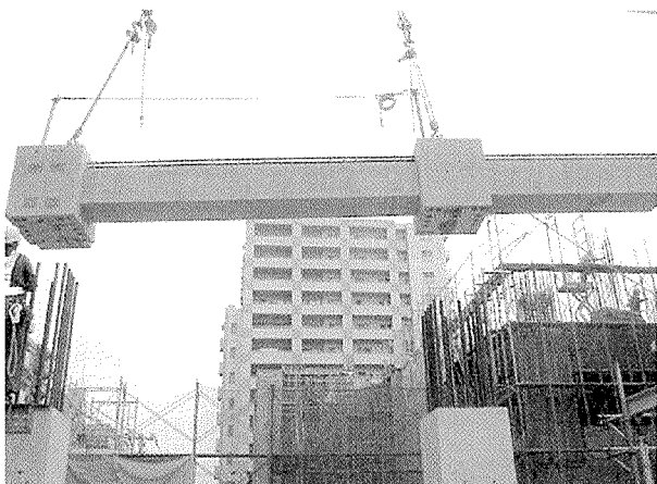
写真 - 5 B方向の梁 PCa 部材の建方
