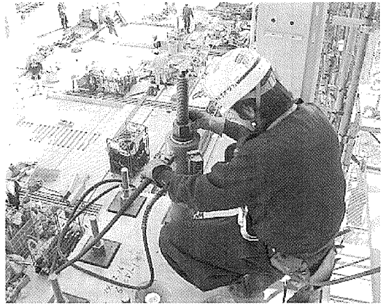
写真 - 6 柱 PC 鋼棒緊張状況
