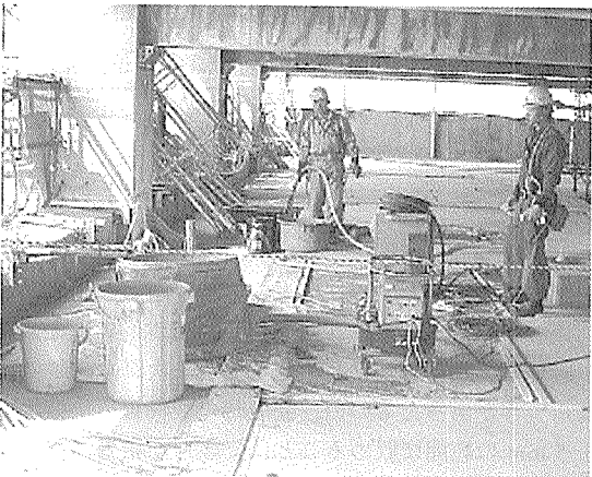
写真 - 15 グラウト中継点 (16階)
