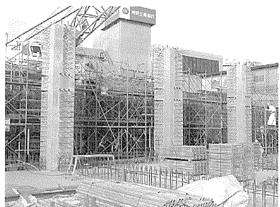
写真 - 2 地下 RC 柱建入れ状況
