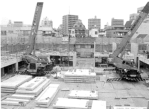
写真 - 5 寮室架設状況
