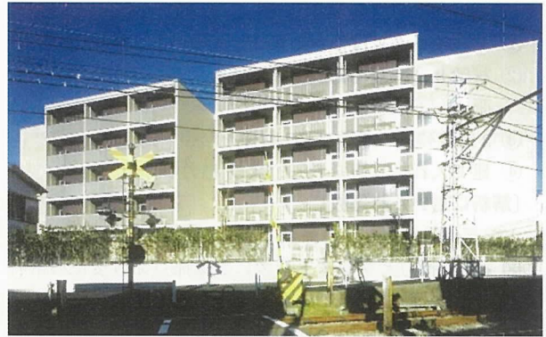
写真 - 1 建物外観
