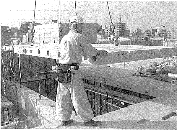
写真-8 床版のセット状況
