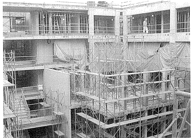
写真 - 6 ミニコモン架設状況
