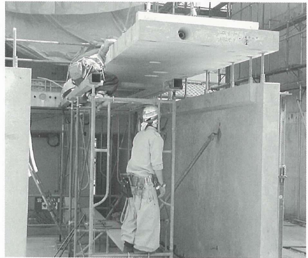
写真 - 7 壁に床版セット状況
