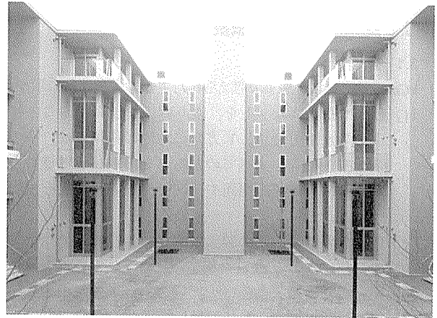
写真-2 建物外観
