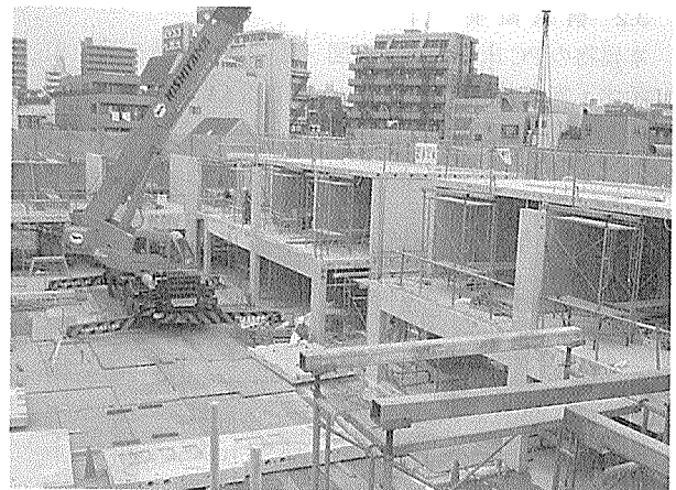
写真-4 架設状況（寮室部分）
