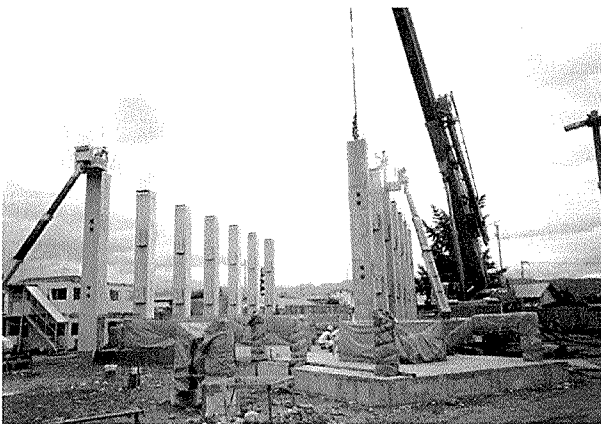
写真 - 3 PCa柱立て込み
