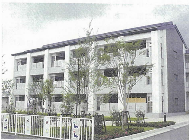
写真-7 1号棟完成写真
