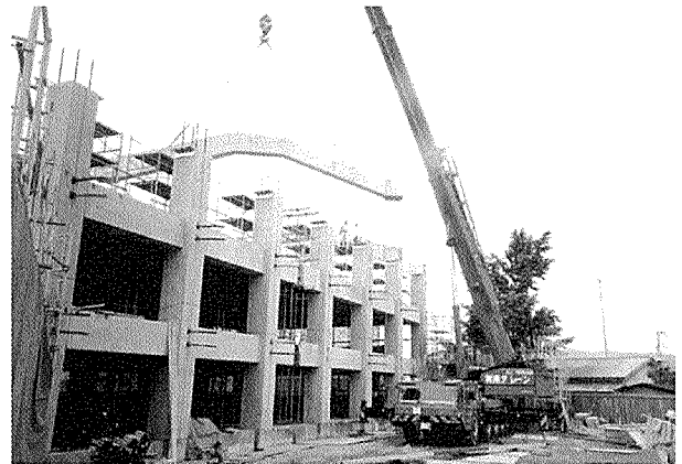
写真 - 5 R階スパン梁架設
