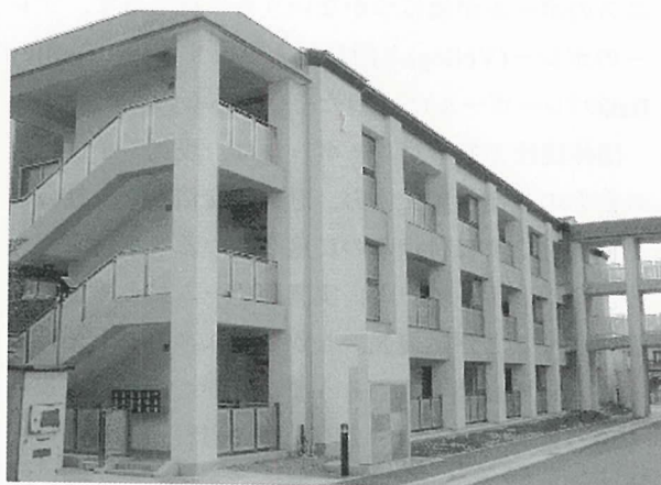
写真-8 2号棟完成写真
