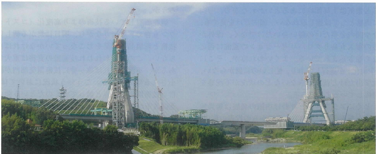
写真-1 施工中の矢作川橋
