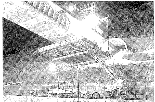
写真-16 架設作業車の夜間解体
