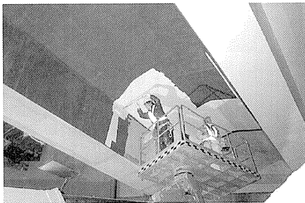
写真-16 仕上げ塗装状況
