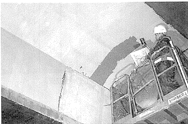
写真-15 表面保護層塗布状況
