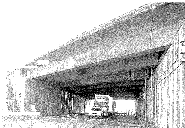
写真-1 施工前全景
