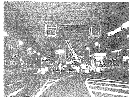
図-18 ストラット架設要領図
