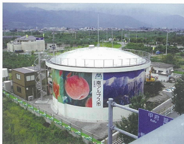
写真 - 2 アルミドーム屋根の写真
