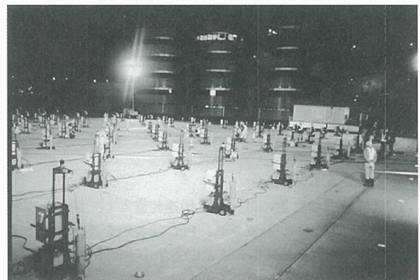
写真-3 リフトアップ施工状況
