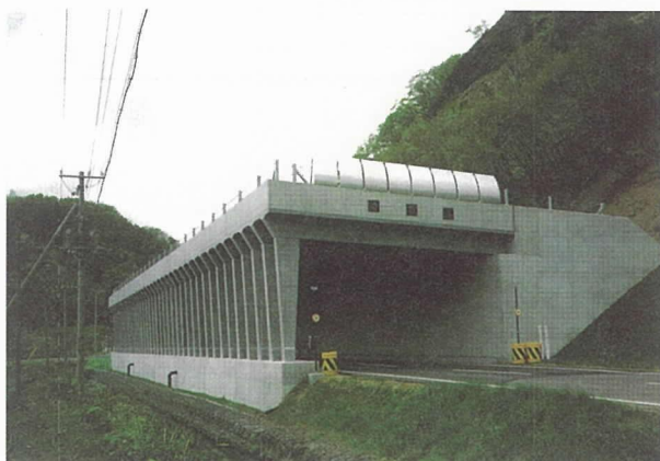
写真 - 1 ロックシェッドの一例
