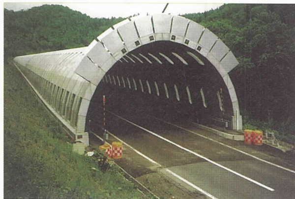
写真 - 2 スノーシェルターの一例
