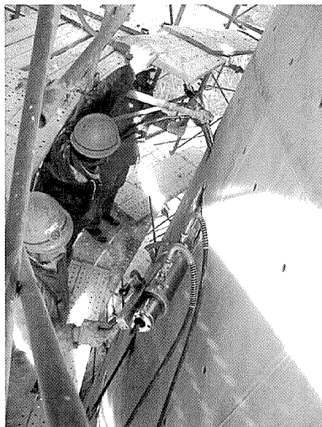
写真 - 7 円周方向 PC 鋼材緊張状況
