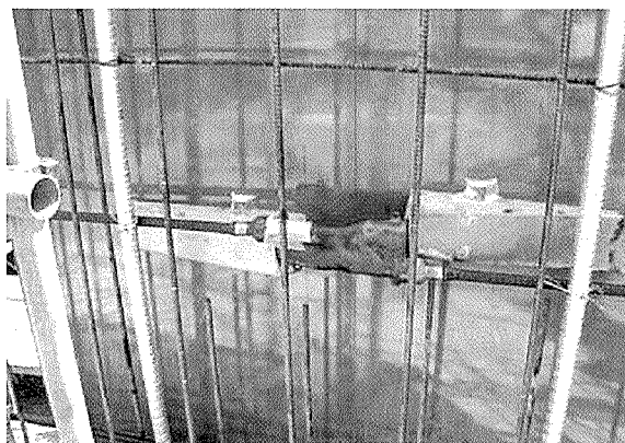
写真 - 6 X アンカー据付け完了
