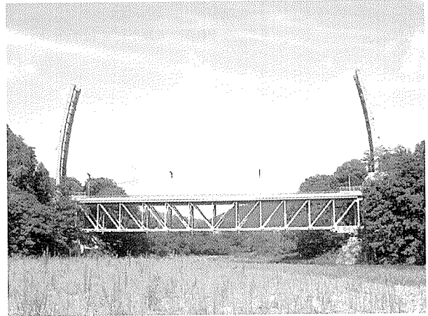
写真 - 6 A1側の1次ロアリング開始
