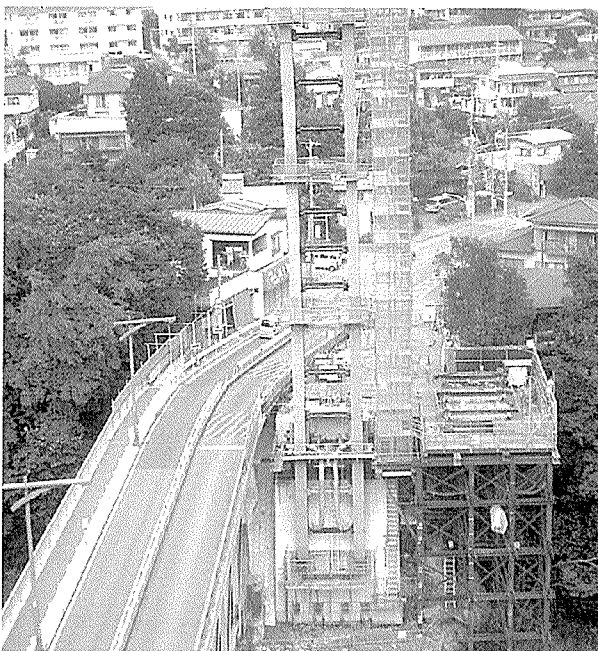
写真-2 架設ヤード
