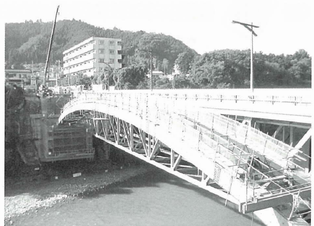
写真-10 メラン材巻立て部の施工
