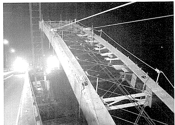
写真 - 7 A1側の2次ロアリング状況
