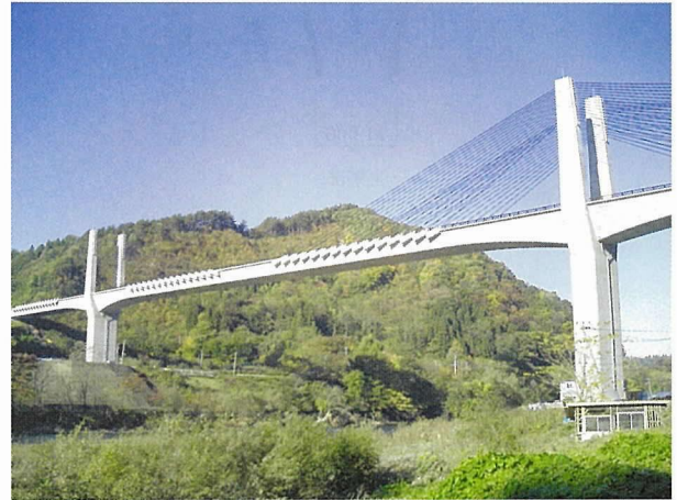
写真 - 1 三戸望郷大橋の全景
