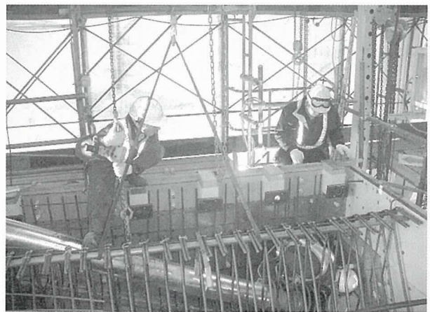
写真-7 斜材据付け作業
