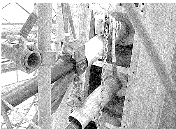
写真-9 主塔サドル部
