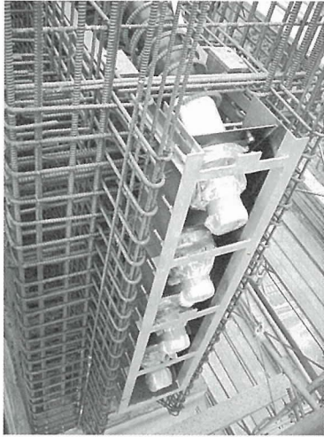
写真-6 サドル部補強
