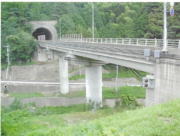
写真-1 完成写真
