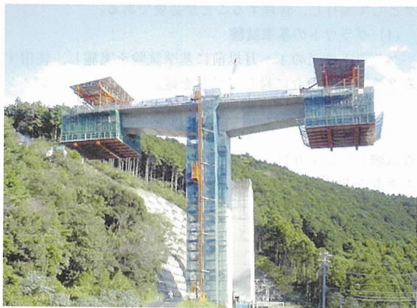
写真-2 P6 柱頭部
