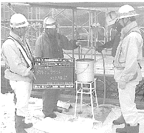
写真 - 6 グラウトの排出確認
