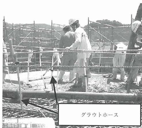
写真-4 打設時のグラウトホース処置
