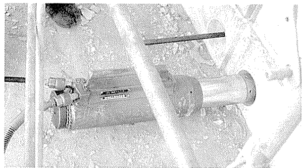
写真 - 4. PC 緊張状況
