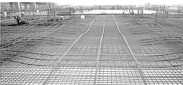
写真 - 3 PC 鋼材配線状況
