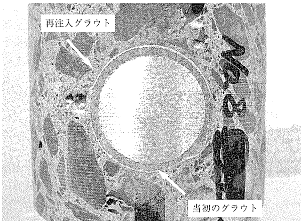
写真-11 グラウト再注入状況
