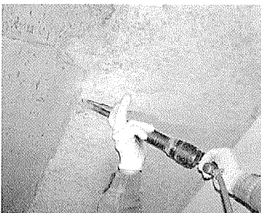
写真-8 ドリルによるはつり状況
