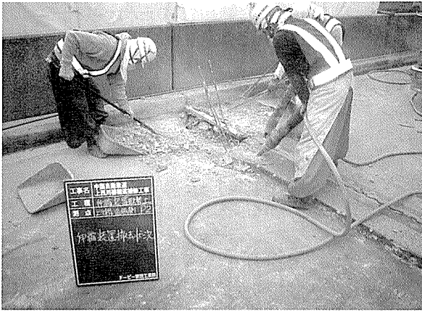
写真 - 8 伸縮装置撤去状況
