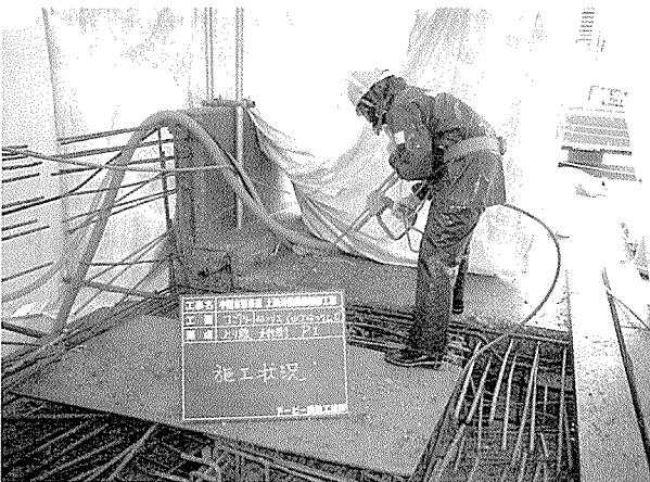
写真 - 9 WJ工法による連結部のはつり状況
