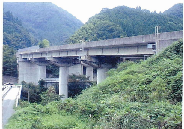
写真 - 1 既設橋梁の全景
