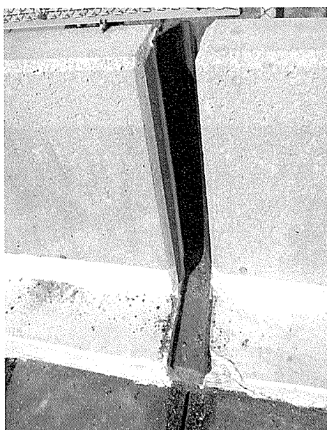
写真-6 地覆部と壁高欄遊間部の止水対策状況
