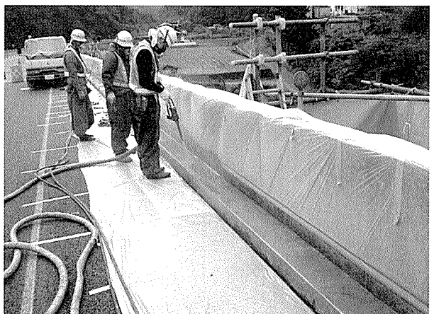
写真 - 12 地覆防水工の施工状況
