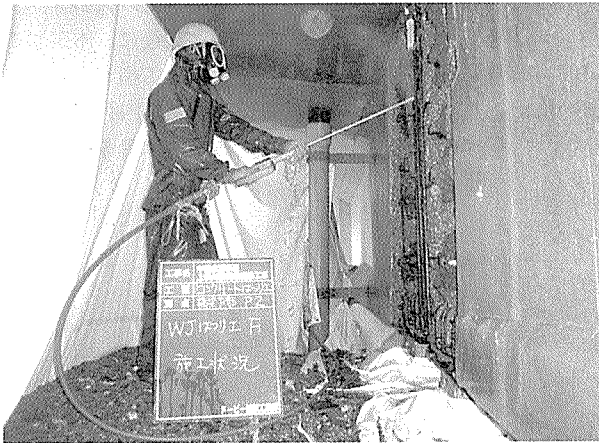
写真 - 13 耳桁側面部のはつり状況
