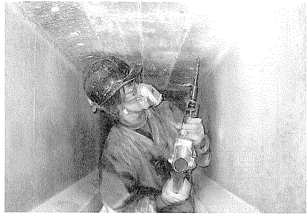
写真-7 アンカー削孔工状況写真
