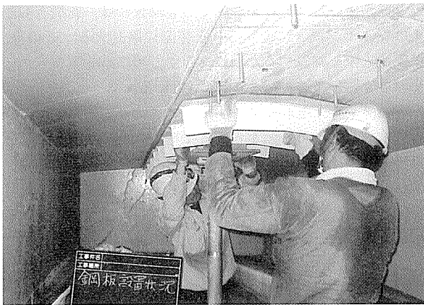
写真 - 8 補強プレート取付け工状況写真
