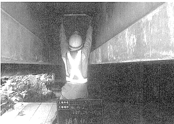
写真-5 現場計測工状況写真
