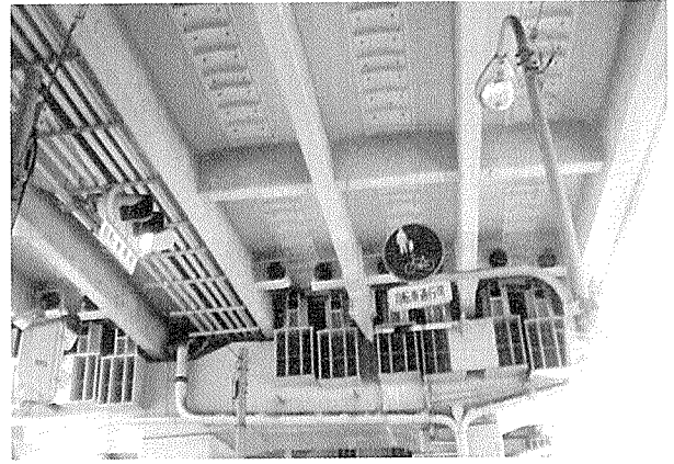
写真 - 10 施工完了写真
