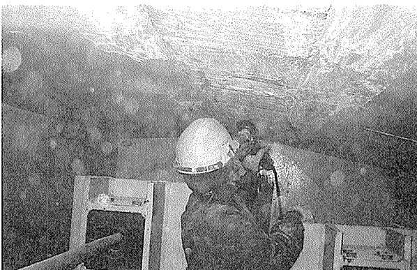
写真-6 コンクリート面処理工状況写真
