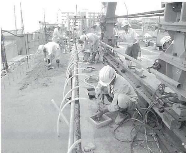
写真 - 15 下面増厚打継面 セメントミルク注入
