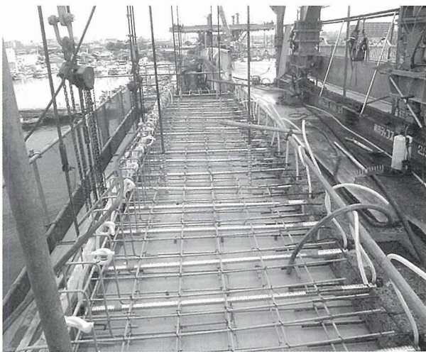
写真 - 14 拡幅コンクリート打設前
