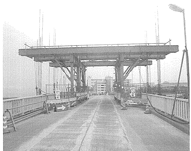
写真 - 12 改造移動作業車 (その 1)
