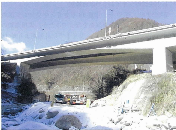
写真-1 橋梁全景
