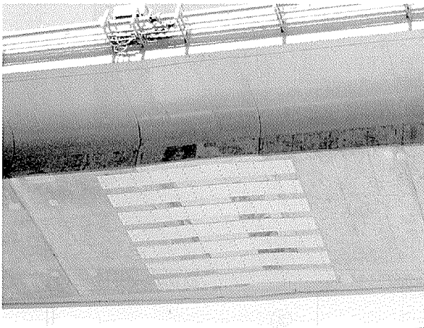
写真-4 床版下面鋼板接着補強
