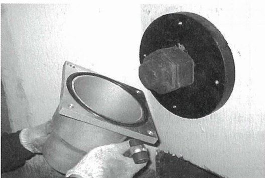
写真 - 3 外ケーブル (F100TS) 設置
