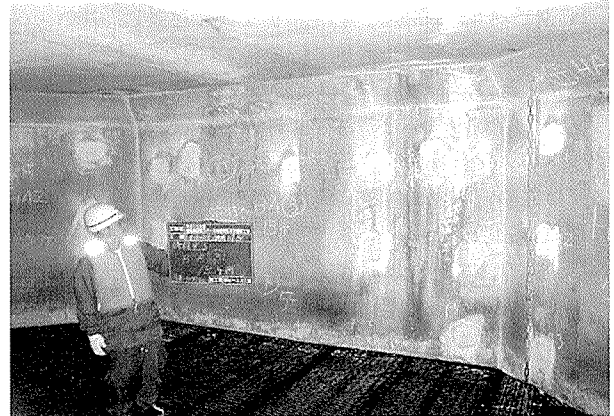
写真 - 5 錆汁処理着手前後状況
