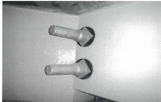
<定着部防錆テープ処理状況>
