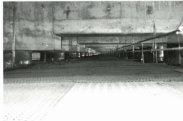
写真 - 2 吊り足場 設置状況
