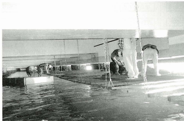
写真 - 2 吊り足場 設置状況
