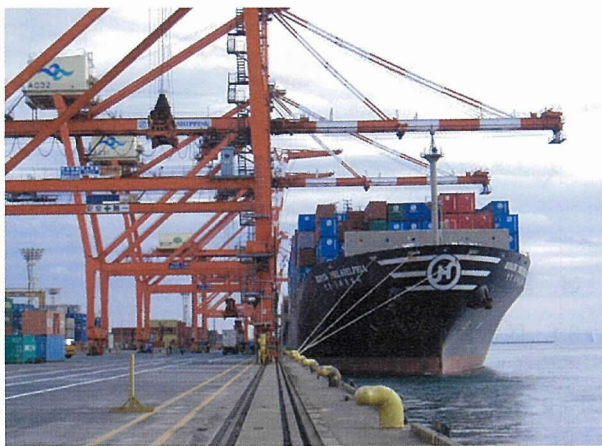
写真 - 1 青海埠頭棧橋現況
