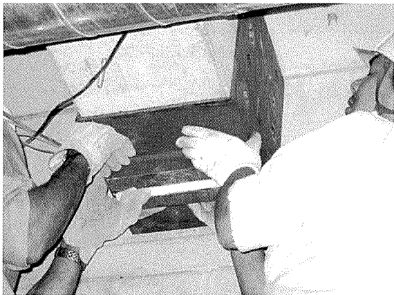
写真 - 2 偏向部の施工状況
