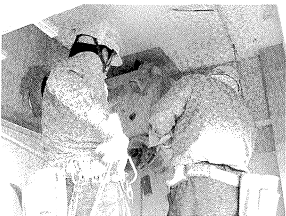
写真 - 4 定着部の施工状況
