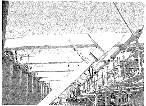
写真-5 ストラットの仮固定
