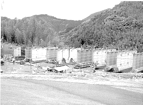
写真-3 下床版プレキャスト部の製作
