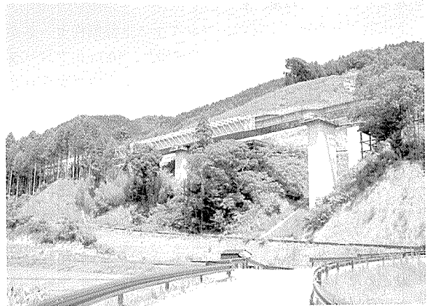
写真 - 10 押し出し架設時の全景
