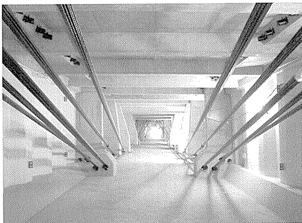
写真 - 9 転用外ケーブルの再緊張完了
