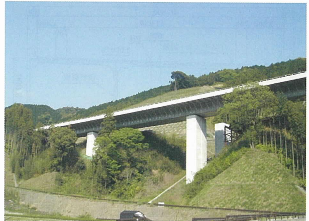
写真 - 1 桂島高架橋の全景
