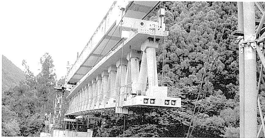
写真 - 5 主桁架設状況
