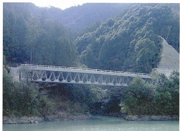
写真 - 1 橋梁全景
