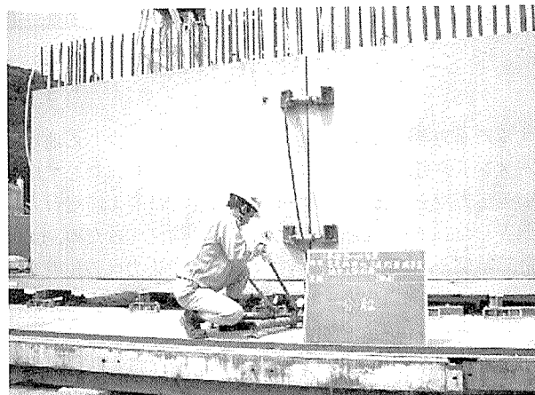
写真-2 セグメント分離状況
