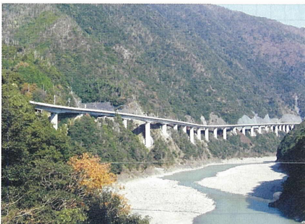
写真-1 七色高架橋の全景
