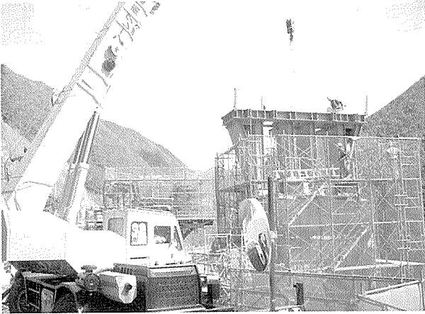
写真-5 掛違部仮ベント据付け
