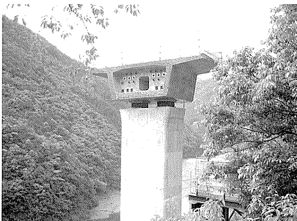
写真 - 3 脚頭部・支承・柱頭部
