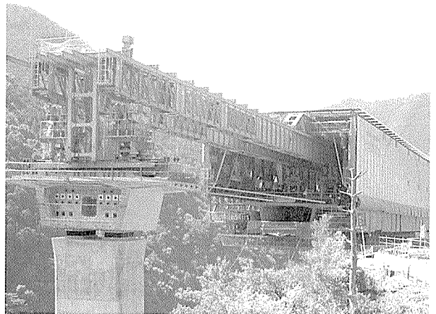
写真-12 仮ケーブル設置
