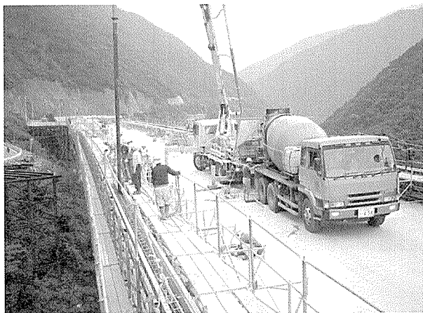
写真 - 13 壁高欄打設
