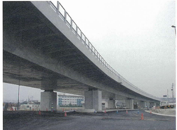
写真 - 1 常滑高架橋
