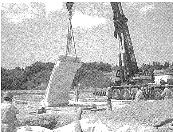
写真 - 3 側面壁の建ち起し
