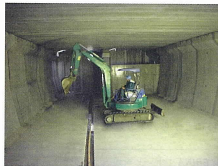
写真-9 完成した貯水槽の内部
