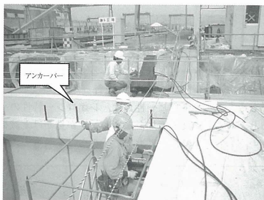
写真-7 横締めPC鋼材の緊張
