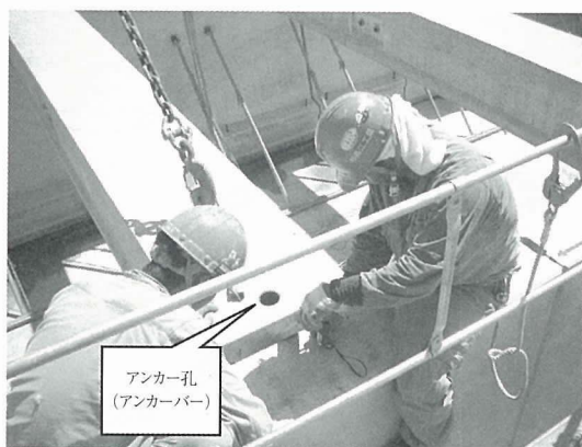
写真-6 屋根梁の架設
