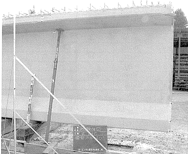
写真-6 端部撮影状況
