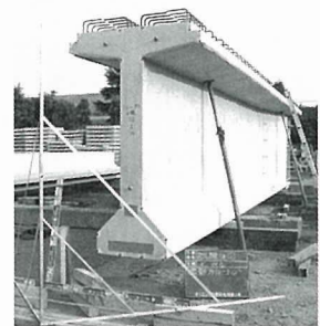
写真-2 コンボ桁
