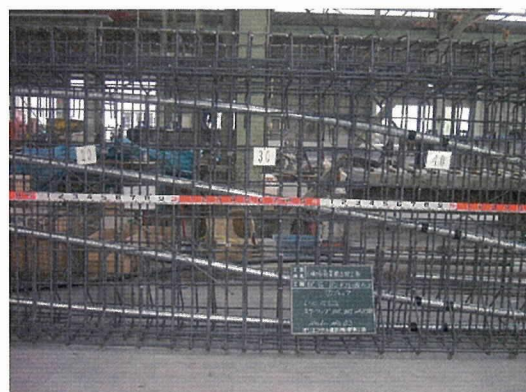
図 - 14 PC 鋼材実写データ
