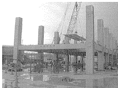
写真 - 4 PC 部材架設および緊張状況
