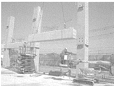
4. ・PC 梁材架設 ・PC 鋼材通線 ・柱, 梁間目地モルタル詰め
