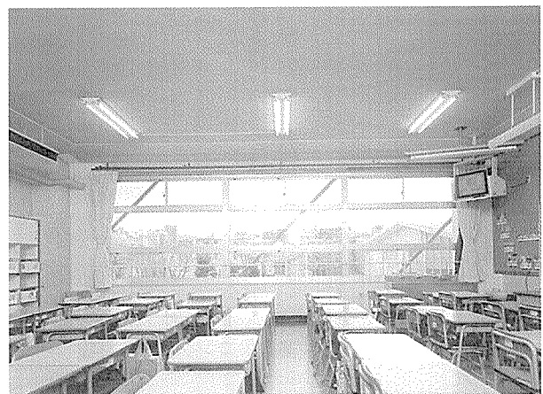
写真 - 13 補強後の室内からの眺望
