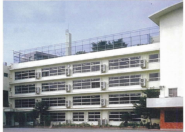
写真 - 1 補強前の建物外観
