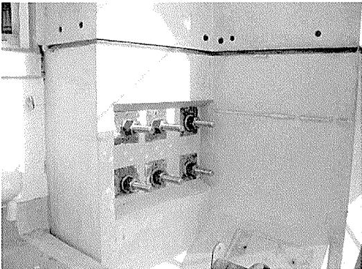
写真 - 6 圧着用 PC 鋼棒挿入
