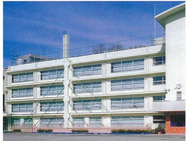
写真 - 2 補強後の建物外観
