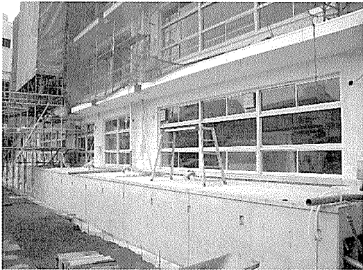
写真 - 4 パラレル基礎梁コンクリート打設
