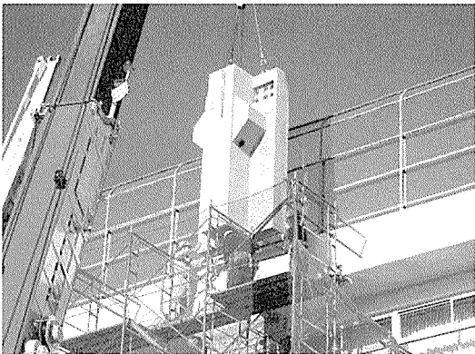
写真 - 5 PCa 柱建て込み
