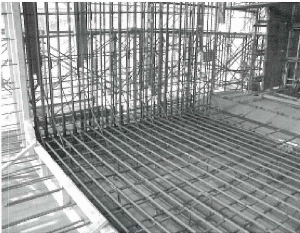
写真-6 先組みエリア
