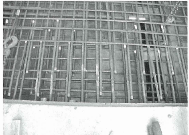
写真-7 鉄筋移動後の継手部
