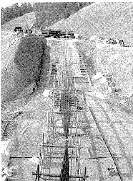
写真 - 10 連続外ケーブルの一括引込み
