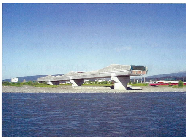
写真-3 施工状況 (平成 17 年 5 月撮影)
