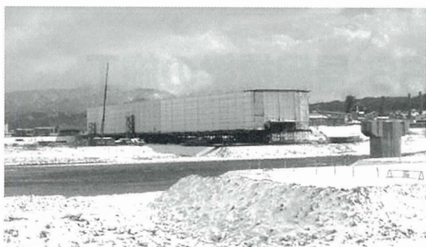
写真-2 養生上屋
