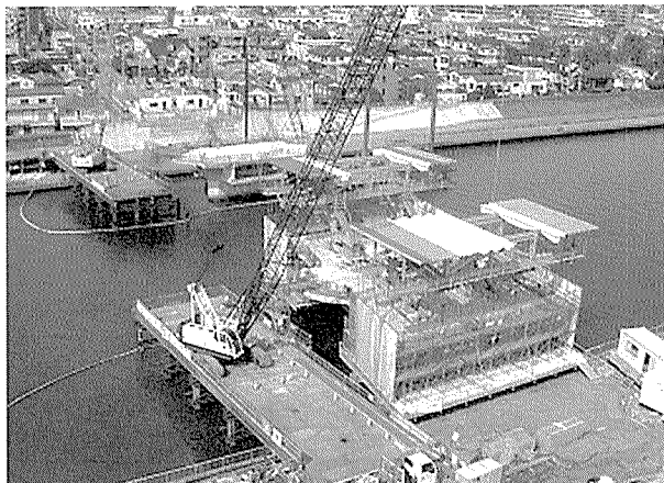
写真 - 4 部材取込み状況
