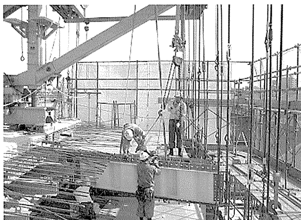
写真 - 5 波形鋼板ウェブ設置状況
