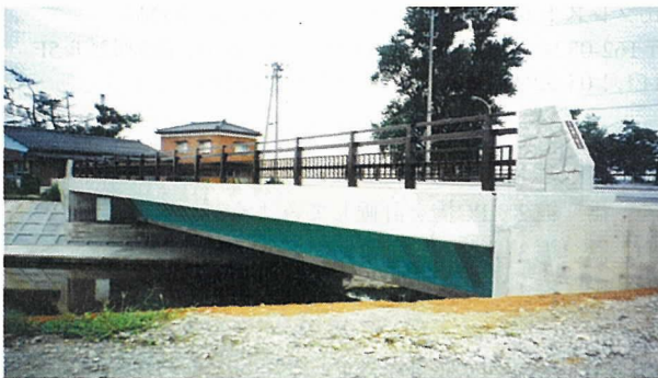
写真-1 新開橋（竣工当時）
