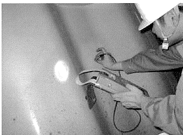
(a) 塗膜厚の測定状況
