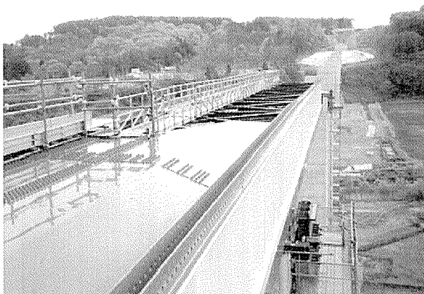
写真 - 3 鳥崎川橋の波形鋼板を利用した手延べ桁
