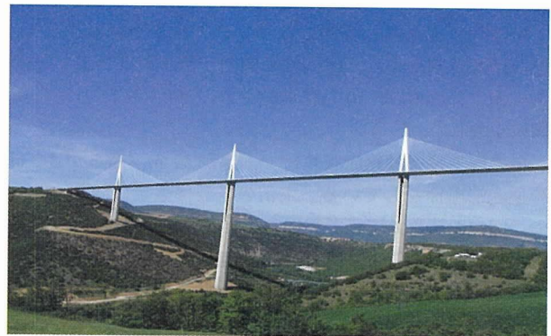
写真 - 7 ミヨ一高架橋
