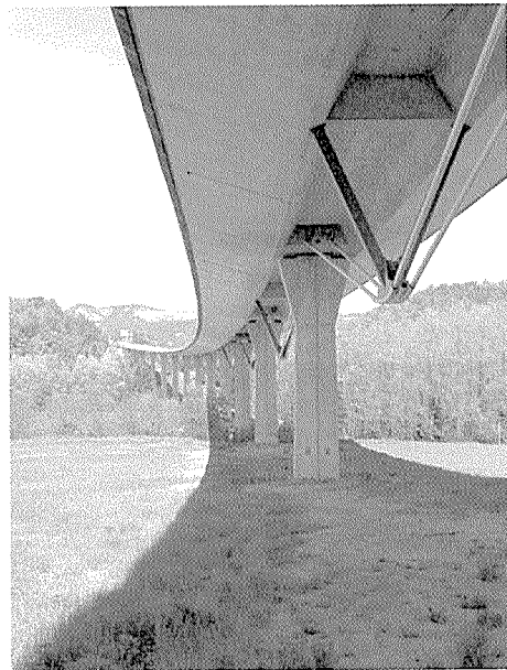
写真 - 8 リエラ・マジョール高架橋
