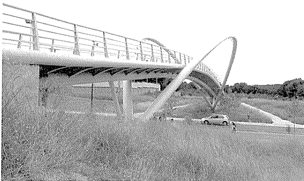
写真 - 11 鋼床版中路アーチ橋（歩道橋）
