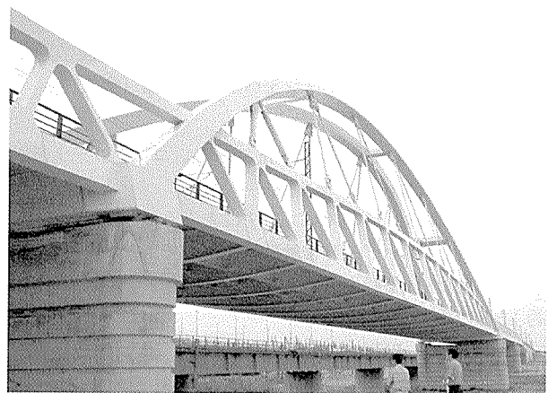
写真 - 14 鋼アーチと鋼トラス（鉄道橋）
