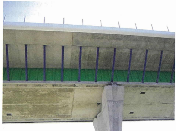
写真 - 5 \phi 32.6 cm の鋼管ストラットとプレート・鋼管ウェブ
