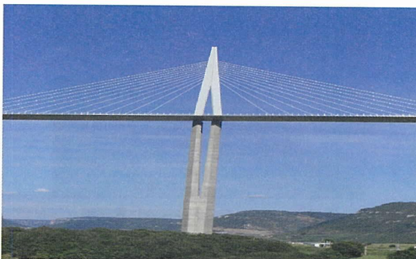
写真 - 6 ミヨ一高架橋の橋脚、主塔、斜材
