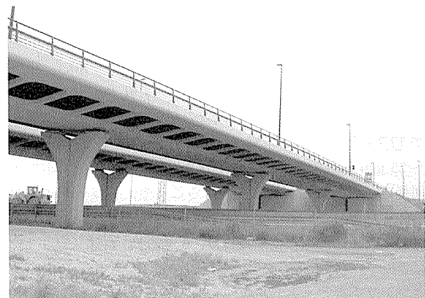
写真 - 10 高速道路 E 90 のオーバーブリッジ
