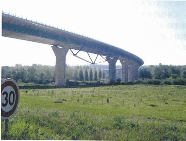
写真 - 4 Meaux (モ一) 高架橋の外観
