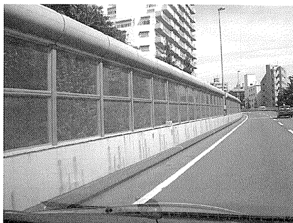
写真 - 1 透光板+新型遮音壁
