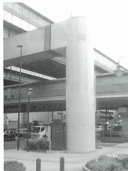
写真-8 鋼橋脚の無溶剤塗装＋光触媒塗装
