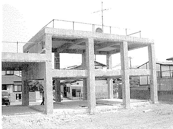
(b) 再利用された RC 造の躯体部分
