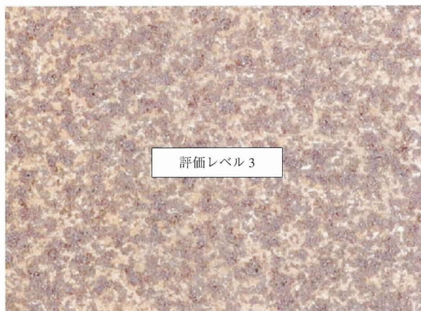
(b) 波形鋼板 内面外観
