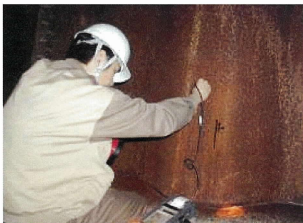
(a) さび厚の測定状況
