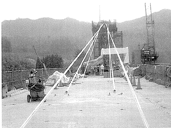
写真-9 仮斜材配置状況
