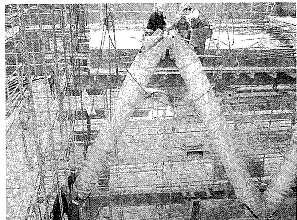
写真-5 鋼トラス材架設状況(張出し施工部)
