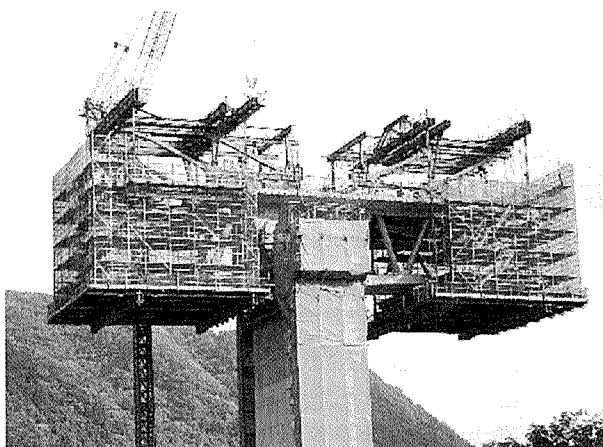
写真-3 大型移動作業車
