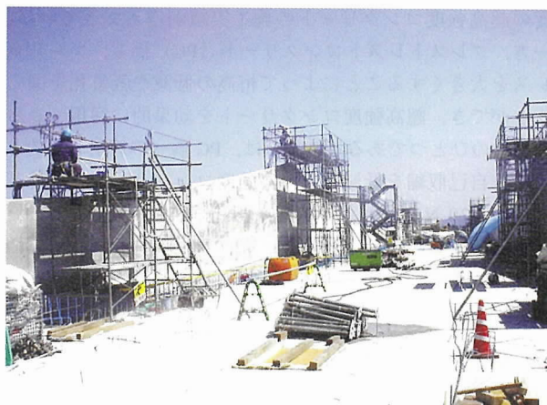
写真 - 8 施工状況
