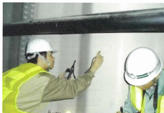
(b) 板厚の測定状況
