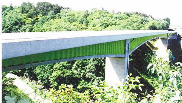
写真-1 本谷橋（竣工当時）
