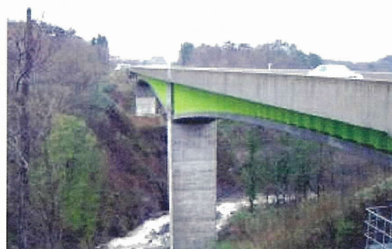
(b) 下流側から
