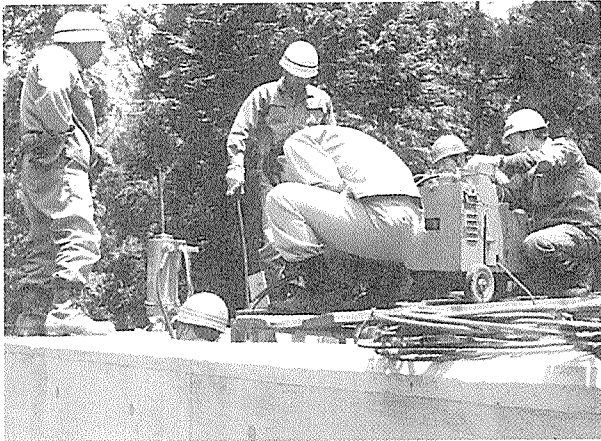
写真 - 3 壁体部の緊張作業状況
