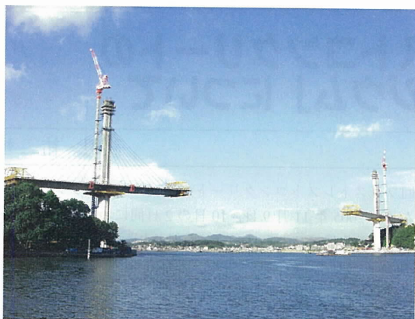
写真 - 4 架設状況
