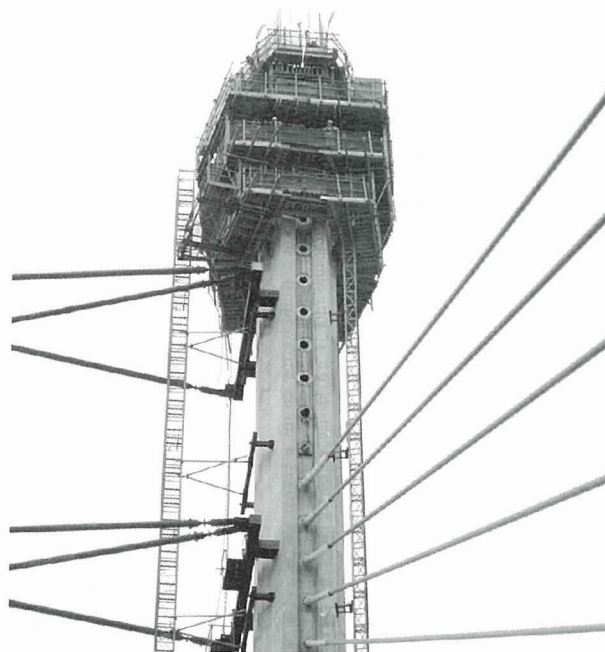
写真 - 6 主塔の施工状況
