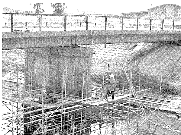
図 - 4 試験状況 (ラーメン高架橋)
