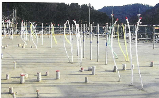
写真 - 3 グラウトホースの配置
